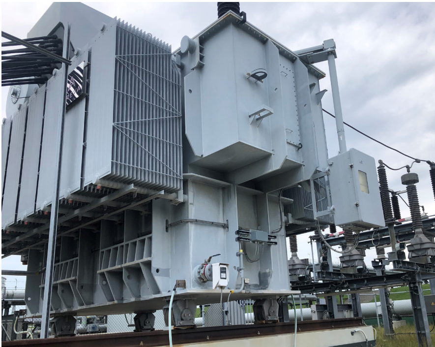
Vaisala MHT410 -asennus Enecon Bio Golden Raand -voimalaitoksen muuntajassa Alankomaissa
