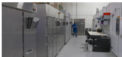
Chambres de stabilité
